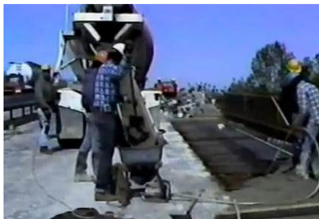
Figura 401 - 1. Toma de muestra de un camión mezclador
